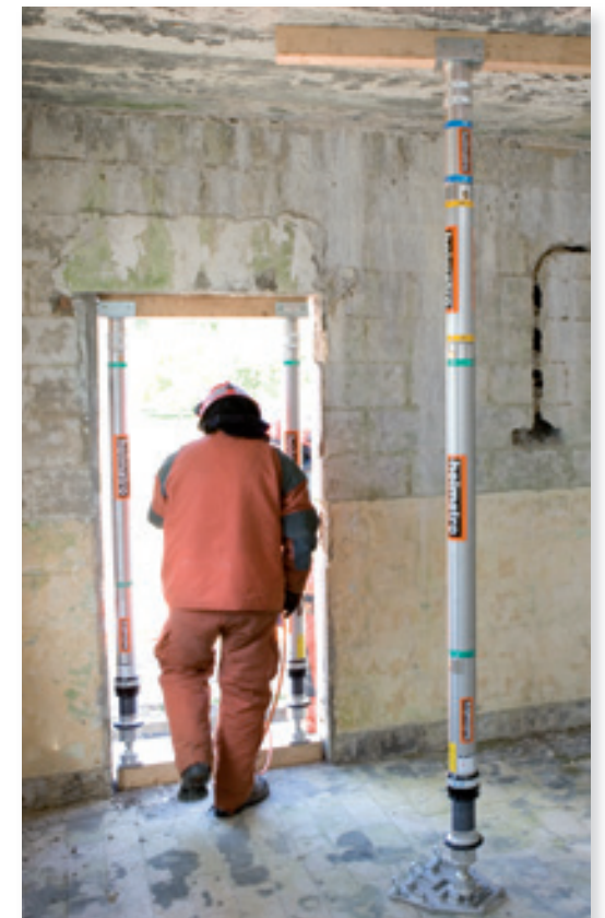
Étais combinés avec une planche en bois pour protéger la voie d'accès et d'évacuation d'un bâtiment effondré.
