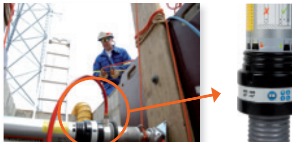
Le système à verrouillage automatique permet un étayage à distance.
