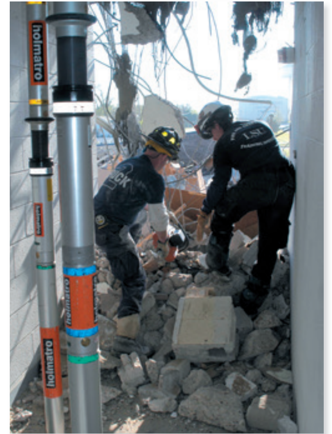
Stabilisation de bâtiments effondrés avec système manuel à verrouillage par contre-écrou.
