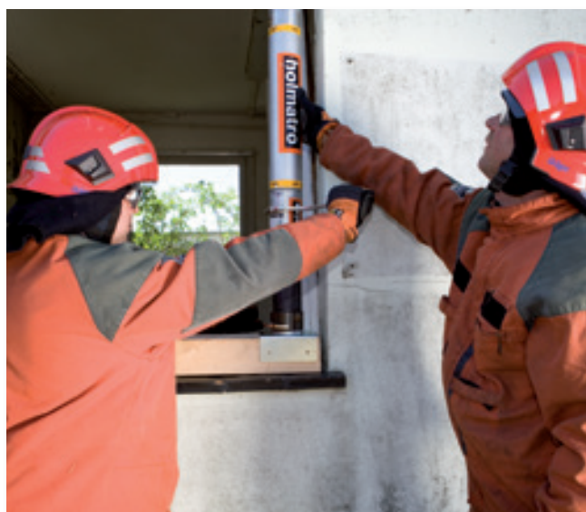
L'étau fileté manuel est utilisé pour étayer une fenêtre. Il peut être sécurisé à l'aide d'une clé à ergots (voir image ci-dessous).
