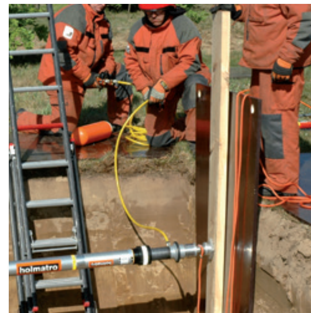
Les étais pneumatiques à verrouillage automatique conviennent parfaitement à un étoyage à distance pour sauvetage en tranchée.
