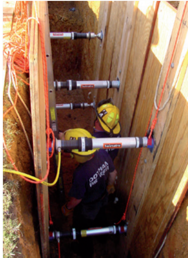
Étaillage de tranchée avec étais pneumatiques à verrouillage automatique.
