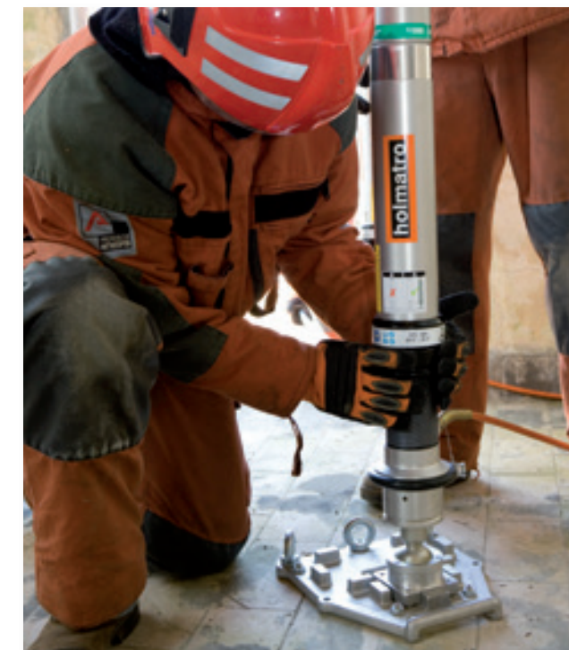
Étai pneumatique à verrouillage par contre-écrou utilisé comme étau manuel pour étayer un bâtiment.
