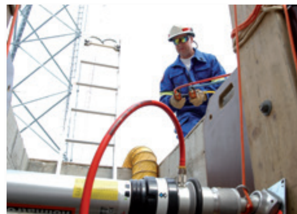
Étayage à distance d'une tranchée
