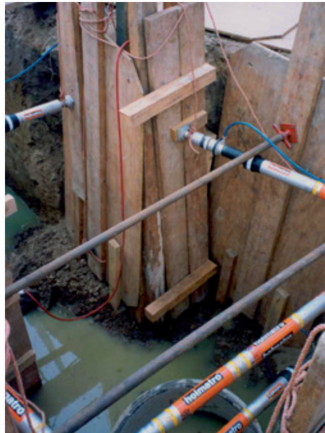
Étais pneumatiques à verrouillage automatique positionnés dans une tranchée.
