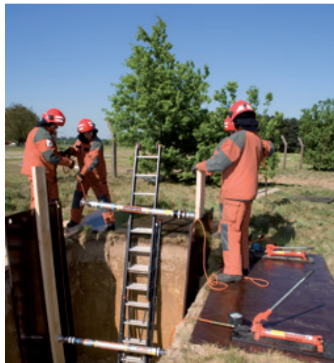
Étais hydrauliques à verrouillage automatique utilisés pour un étaillage à distance.
