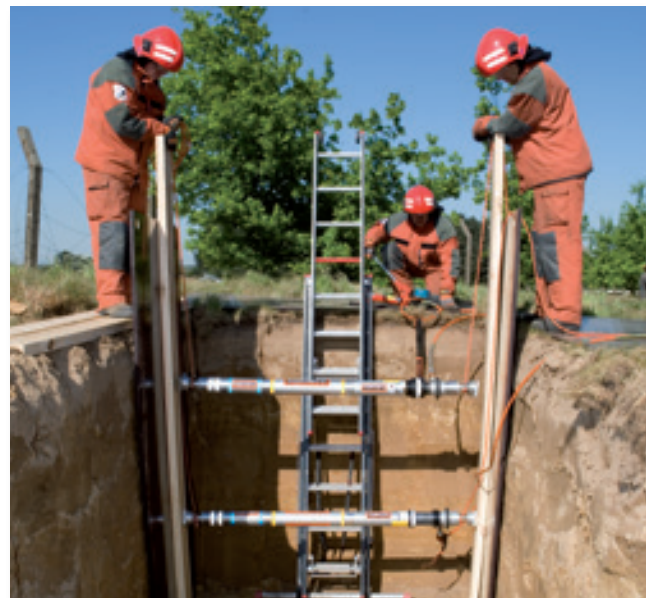
Étaillage à distance avec étais hydrauliques à verrouillage automatique.
