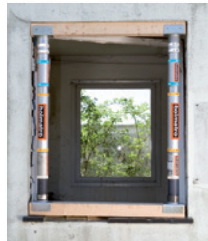
Étais manuels avec rallonges, têtes de soutien de poutre et planche en bois pour stabiliser une fenêtre.
