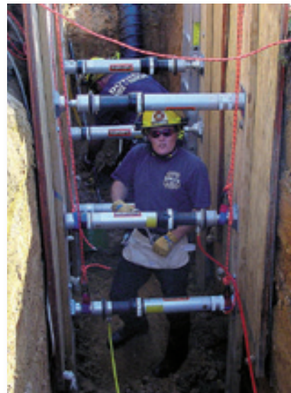
Sauvetage en tranchée
