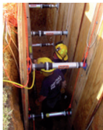
Étayage de tranchée avec étais pneumatiques à verrouillage automatique.
