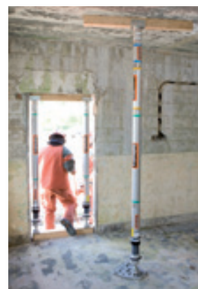
Étau ponctuel pour protéger une voie d'évacuation.
