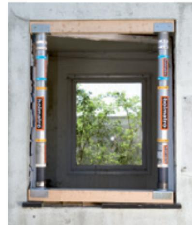
Mechanische Stützen mit Verlängerungsrohren, Balkenauflagern und Balken, die in einer Fensteröffnung benutzt werden.
