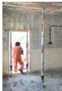
Deckenstütze zur Absicherung eines Ausgangsweges.
