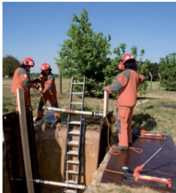
Hydraulische Auto-Lock Stützen, die für fernbedientes Stützen benutzt werden.
