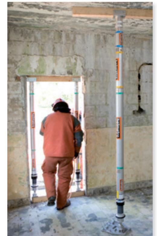
Stützen, die mit Balken benutzt werden, um die Zugangs- und Ausgangswege eines eingestürzten Gebäudes zu sichern.
