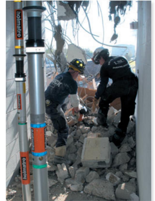
Das Stützen eines eingestürzten Gebäudes mit einem mechanischen System mit Sicherungsmutter.
