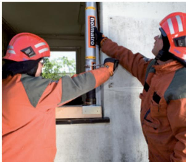
Die Anwendung einer mechanischen Stütze mit selbstsicherndem Gewinde zum Stützen eines Fensters. Dieser Typ wird mit einem Hakenschlüssel gesichert.
