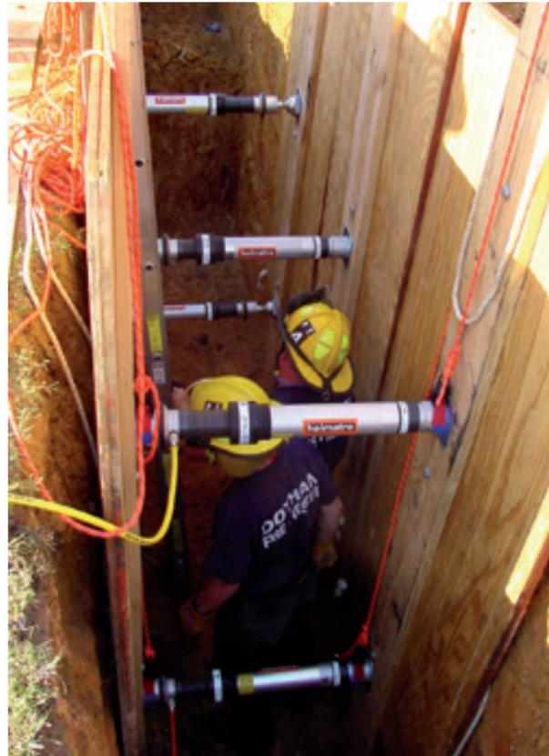
Ein Graben, der mit pneumatischen Auto-Lock Stützen gestützt wird.
