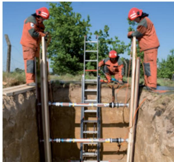
Fernbedientes Stützen mit hydraulischen Auto-Lock Stützen.
