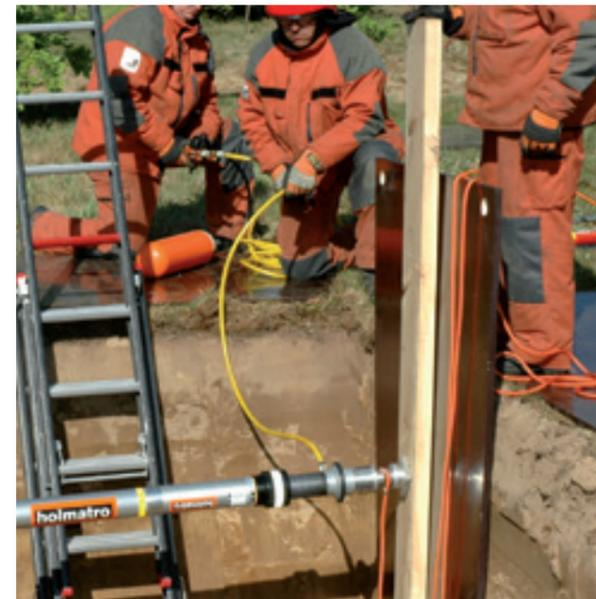
Pneumatische Auto-Lock Stützen sind besonders gut für fernbedientes Stützen bei eingestürzten Gräben geeignet.
