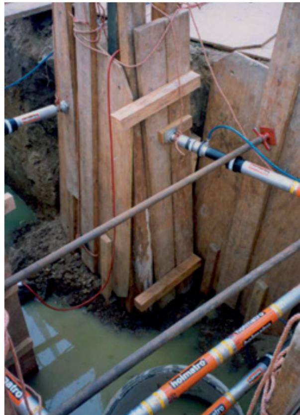
Pneumatische Auto-Lock Stützen in einem Graben.
