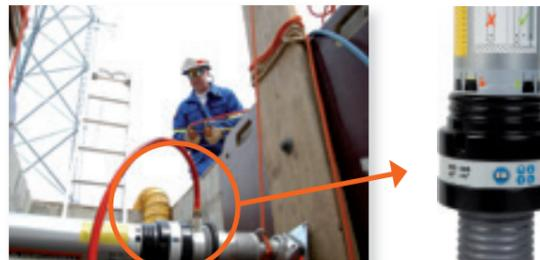
Das Auto-Lock System ermöglicht fernbedientes Stützen
