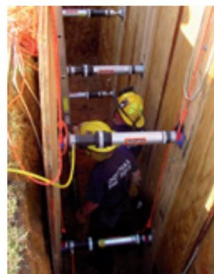
Stützen eines Grabens mit Auto-Lock Stützen.
