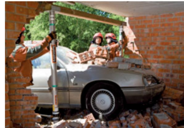
Das Aufstellen von zwei Stützen mit Balkenauflagern in einem eingestürzten Gebäude. Die hydraulischen Stützen mit Sicherungsmutter werden mithilfe einer Handpumpe kontrolliert ausgefahren.
