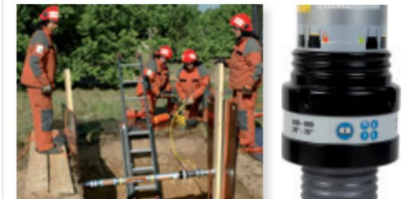
Bei dem Auto-Lock System wird automatisch gesichert, wodurch fernbedientes Stützen ermöglicht wird. Dabei handelt es sich um ein Verfahren, wobei eine Stütze in einer gefährlichen Umgebung aufgestellt wird und dann aus sicherer Entfernung durch pneumatischen oder hydraulischen Druck ausgefahren wird. Nur pneumatische und hydraulische Stützen können deshalb mit diesem Auto-Lock System ausgestattet sein.
