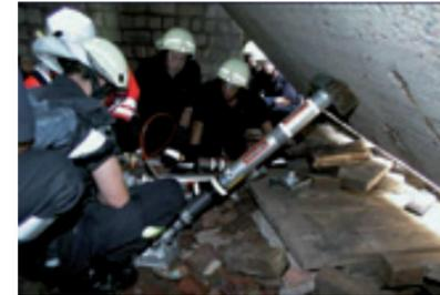
Das Stützen und Heben von Trümmern mit einem hydraulischen System mit Sicherungsmutter.
